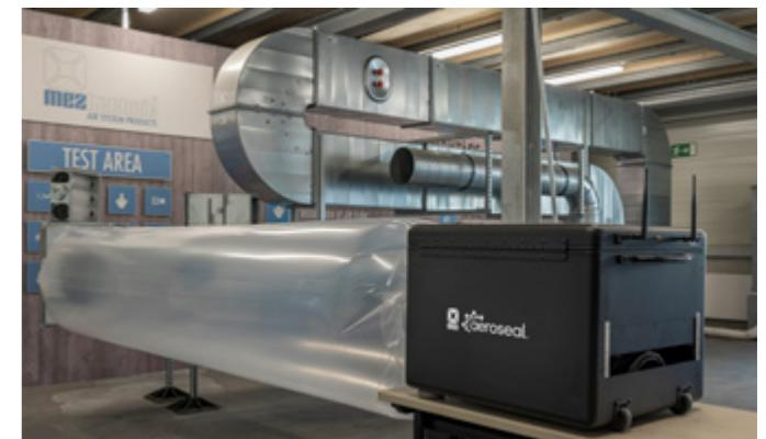
Einer der Hauptbestandteile der DEMO-AREA ist ein Luftkanal mit sowohl runden als auch eckigen Strängen, ergänzt durch Jalousiekappen und weitere technische Elemente. Dank integrierter Revisionsöffnungen kann der Innenbereich des Kanals leicht eingesehen werden. Dies bietet eine realitätsnahe Umgebung für praktische Übungen.
